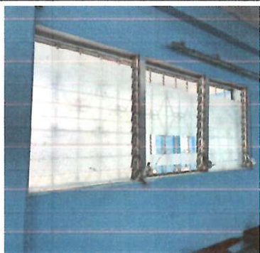
Foto 1: Sustitución de ventanas de aluminio por ventana de pvc.
