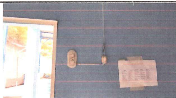
Foto 6: Instalación de tomacorriente: con canaleta, fijado con tarugos y tornillos.
