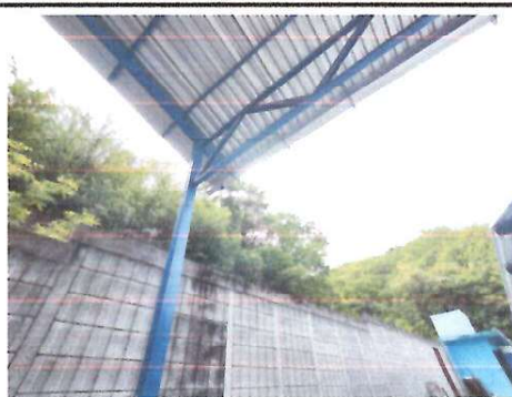
Foto 4: Reemplazo de canal de agua pluvial.
