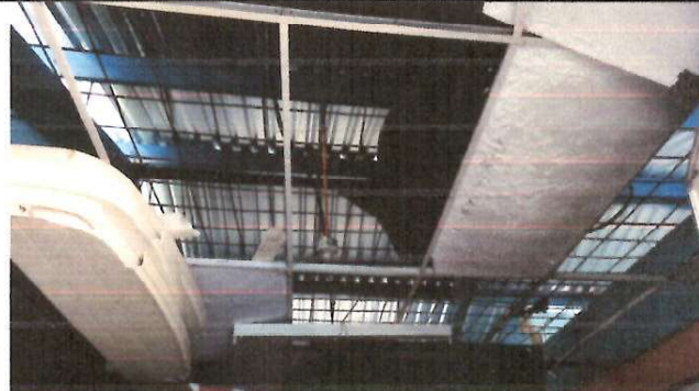
Foto 2: Sustitución de cielo falso en área de bodega.
