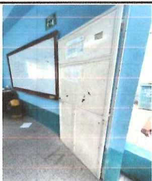
Foto 3: Mantenimiento de puerta: Lijado, pulido y pintura.
